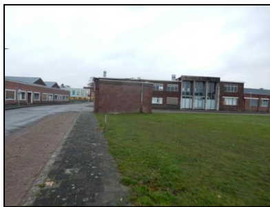
Figuur 3. Westkant projectlocatie met transformatorhuisje.
