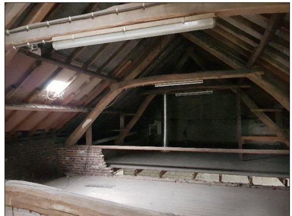
Figuur 9. Binnenkant te verbouwen gedeelte
