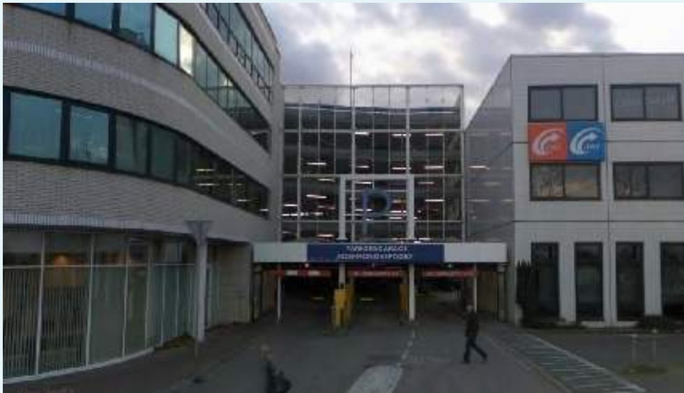
Figuur 1 foto parkeergarage
