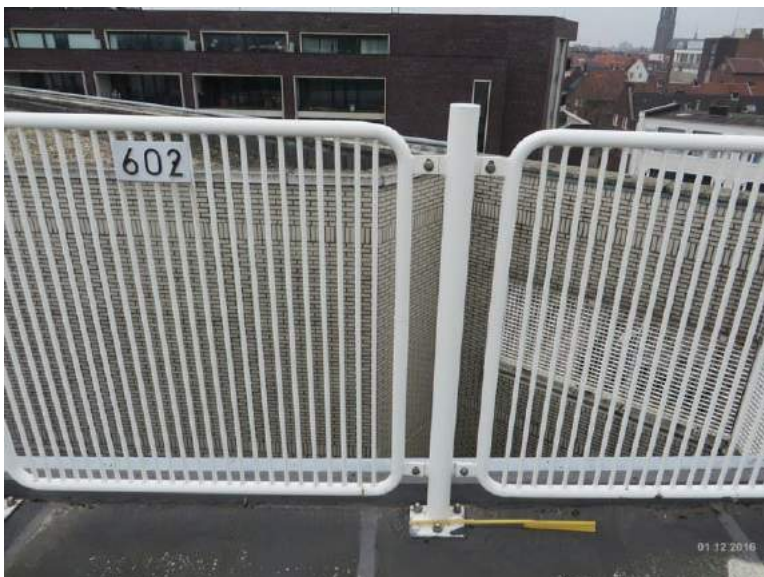
Figuur 5.3 Bevestiging hekwerk kanaalplaatvloer
