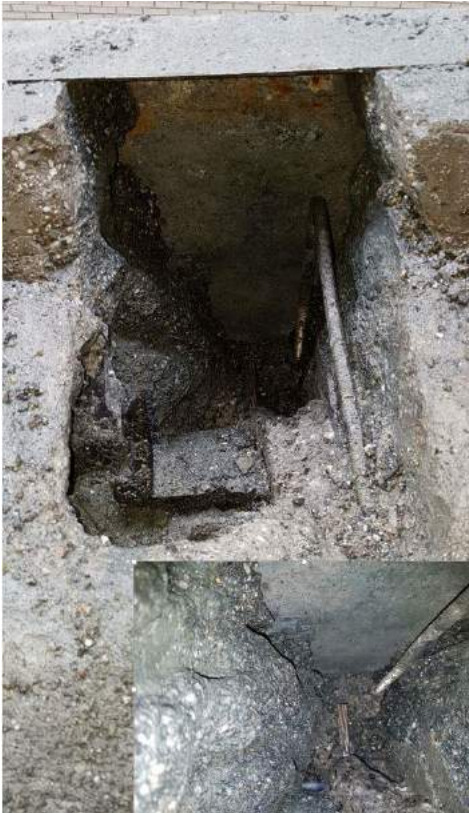
Figuur 5.1 Bevestiging staalconstructie aan kanaalplaatvloer
