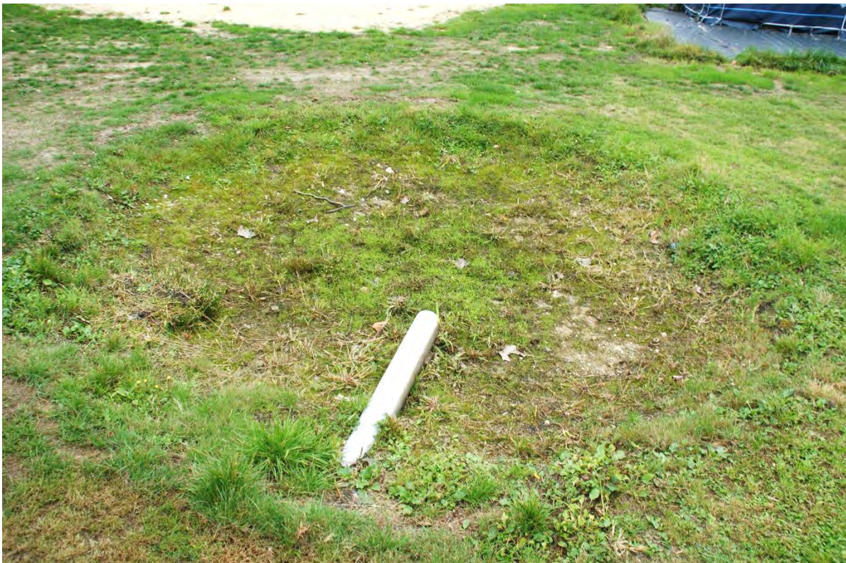
Figuur 5.16 Kuil naast een standplaats die voor afvoer van het regenwater naar de geul moet zorgen. Staat in natte perioden tot aan het maaiveld vol met water.
