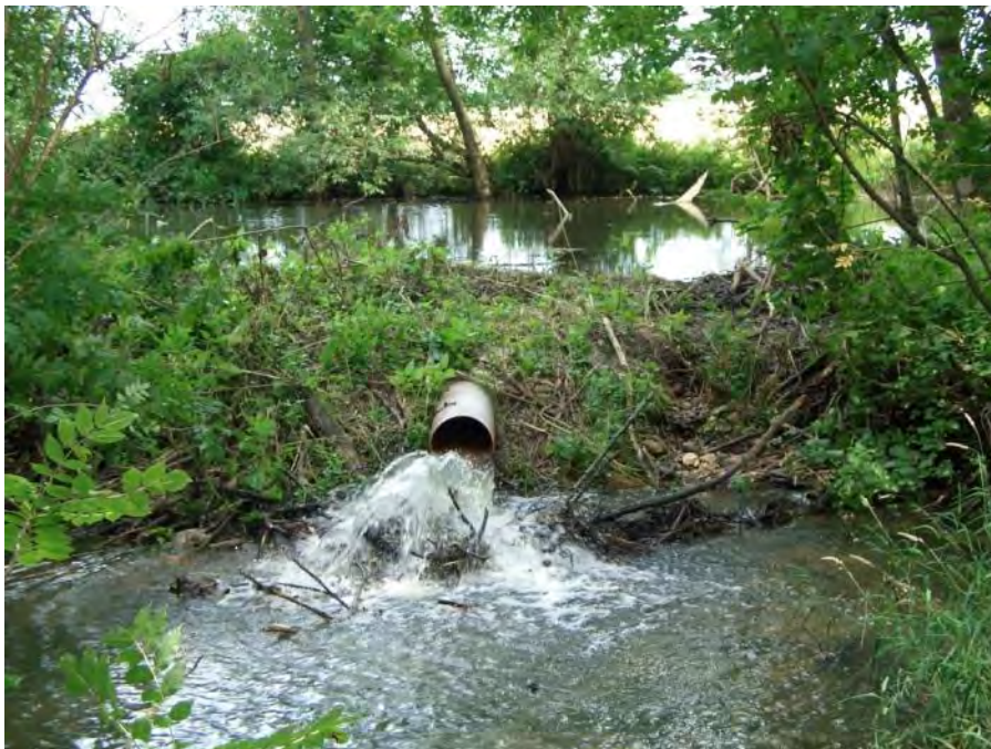
Foto 3. Een beaverdeceiver door een beverdam (Foto: Gerhard Schwab).
