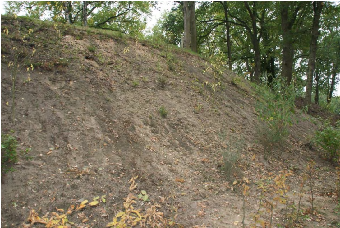
Figuur 5.2 Het overgrote deel van de helling is kaal waardoor er een grote kans op erosie tijdens regenbuien is
