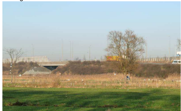
Figuur 8. Het meest noordelijk deel van het plangebied, met zicht op het viaduct van de Broekweg onder de provinciale weg door. Foto genomen richting het noorden
