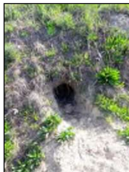
Figuur 5. Pijp das in talud N295, in het oostelijke gedeelte van de planlocatie.
