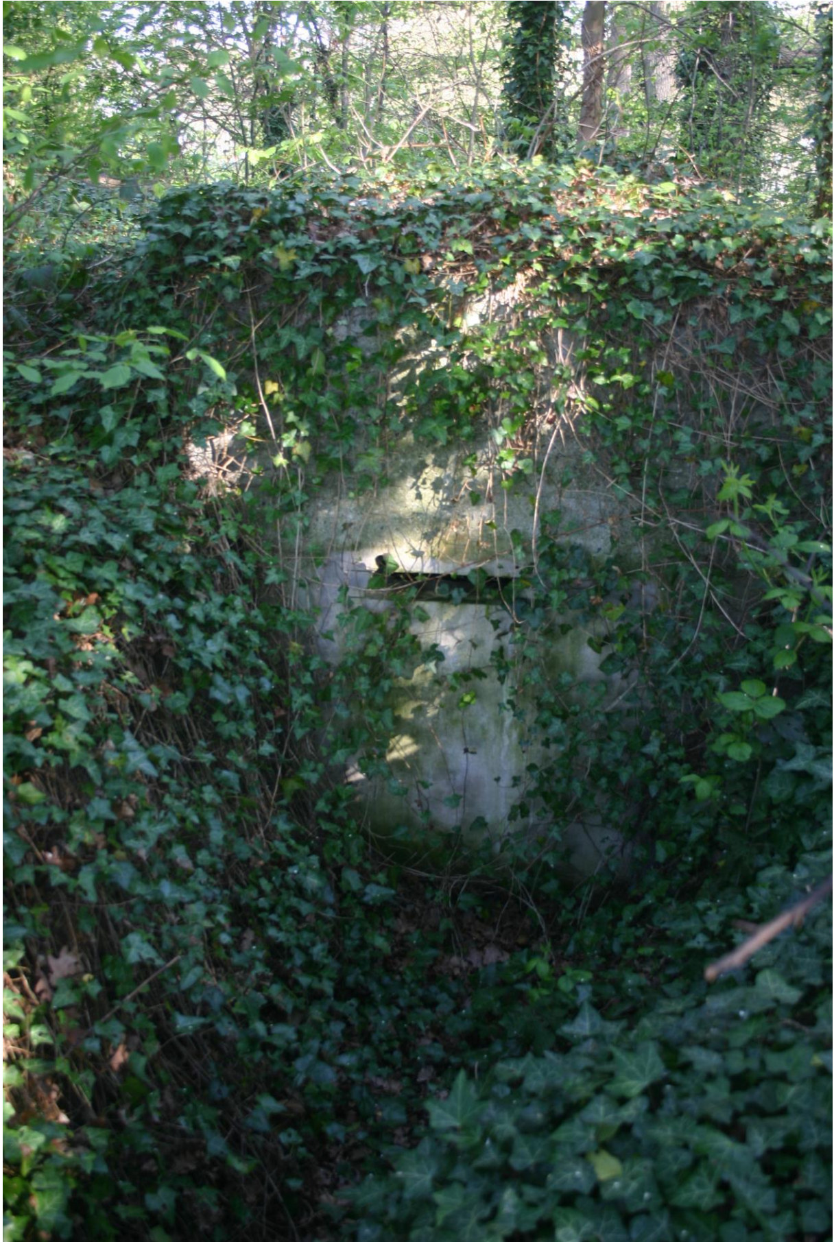
Figuur 5. De met klimop overwoekerde bunkeringang.
