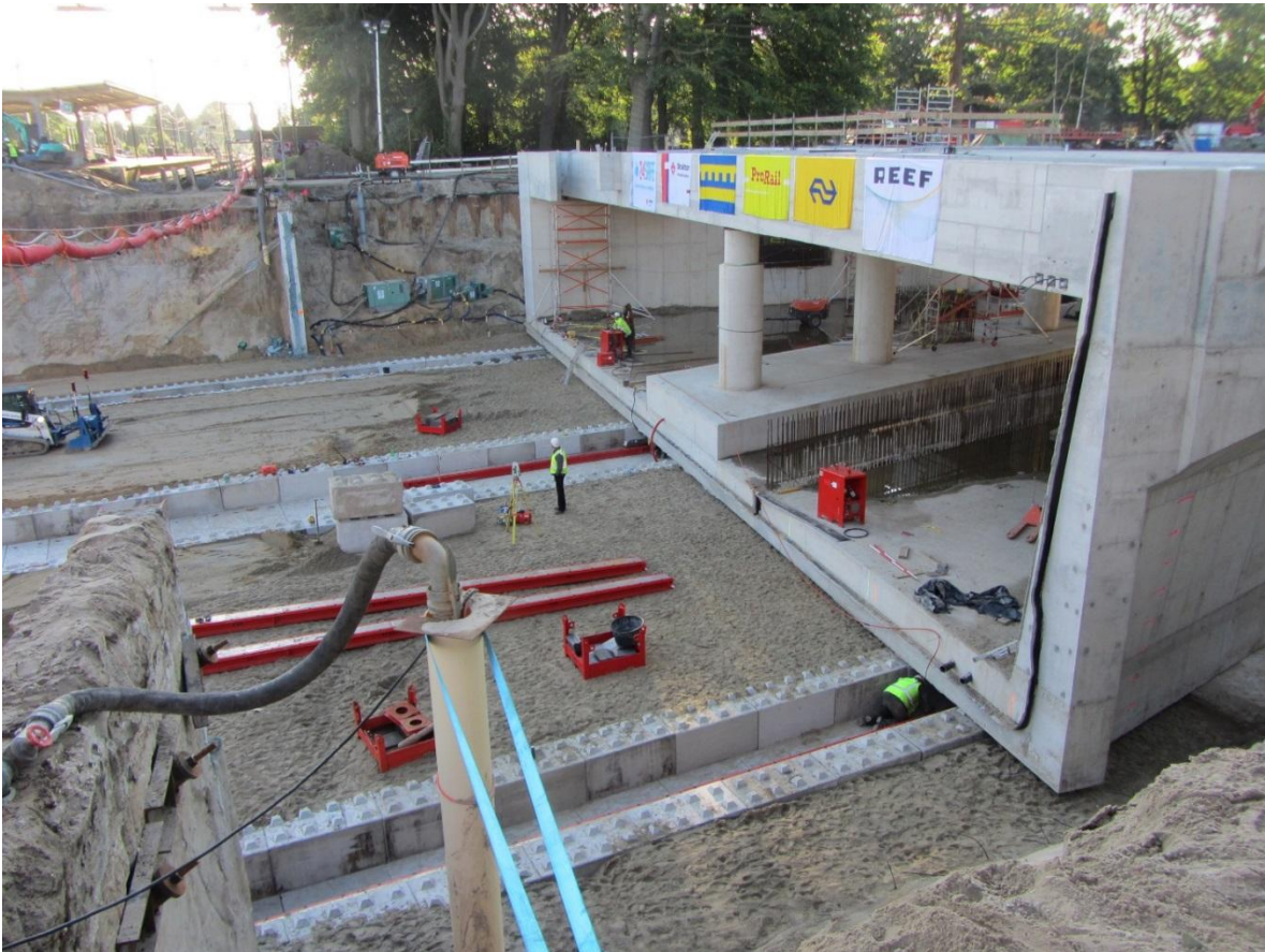
Figuur 6 Harderwijk. Referentie inschuiven spookruisend deel op staal
