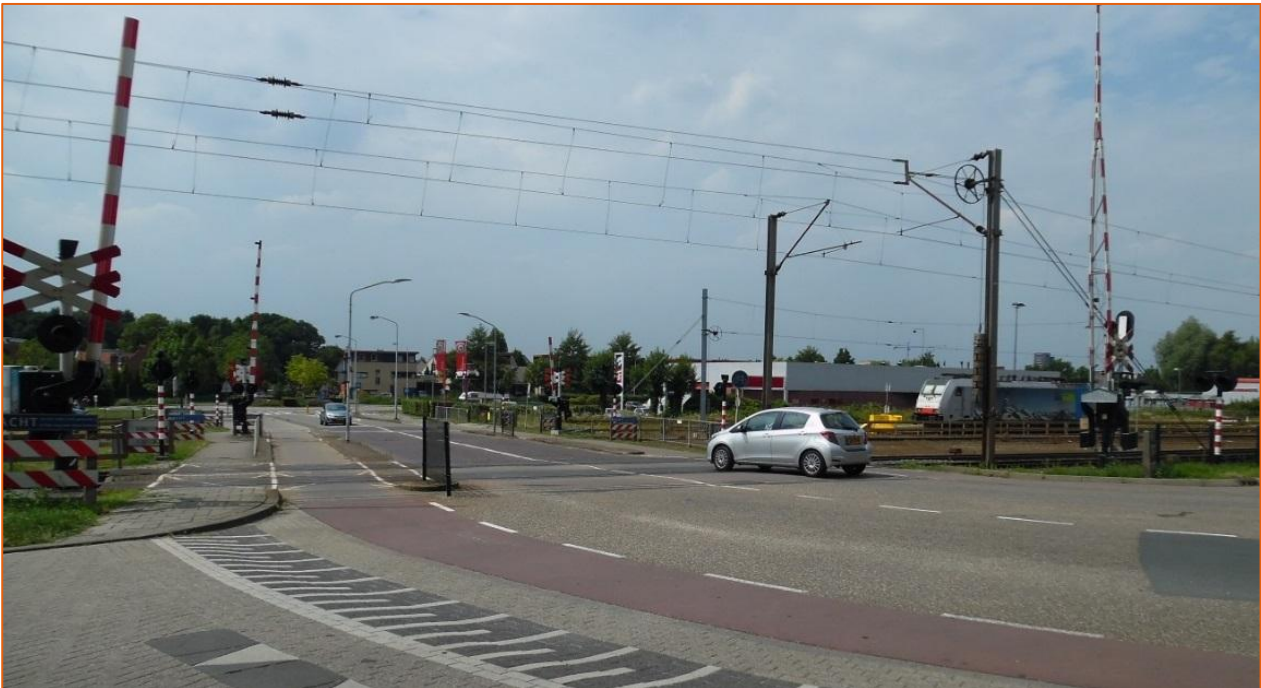
Figuur 1 bestaande overweg Vierpaardjes/Broekestraat
