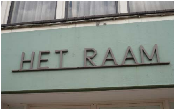
Enkelzijdig reclameobject plat op de gevel.
