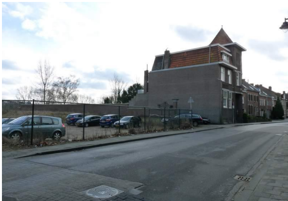
Fig. 5. Zicht op het plangebied vanaf de Pontanusstraat. Foto genomen richting het zuiden
