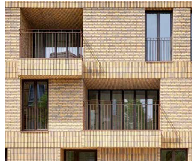
Figuur 3.29 Loggia's, balkons, terugliggende gevelopening (negge) en metselwerk banden geven de vorm aan de gevel
