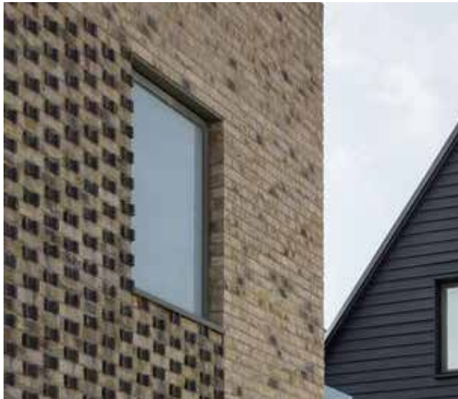
Figuur 3.11 Kozijn deels weggewerkt in de detaillering
