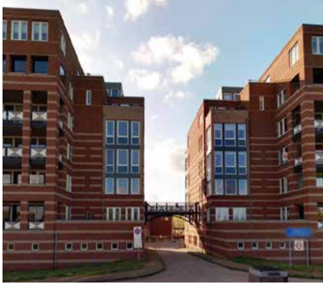
Figuur 3.25 Doorgang tussen twee gebouwen
