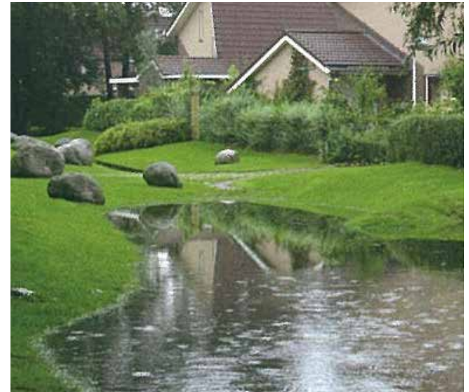
Figuur 4.10 Het afvloeien van het water richting de grotere buffer
