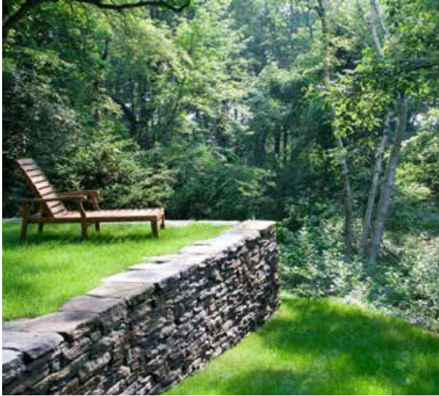
Figuur 3.51 Gebouwde afscheiding / schanskorf markeert overgang privé-openbaar aan achterzijde vrijstaande woningen
