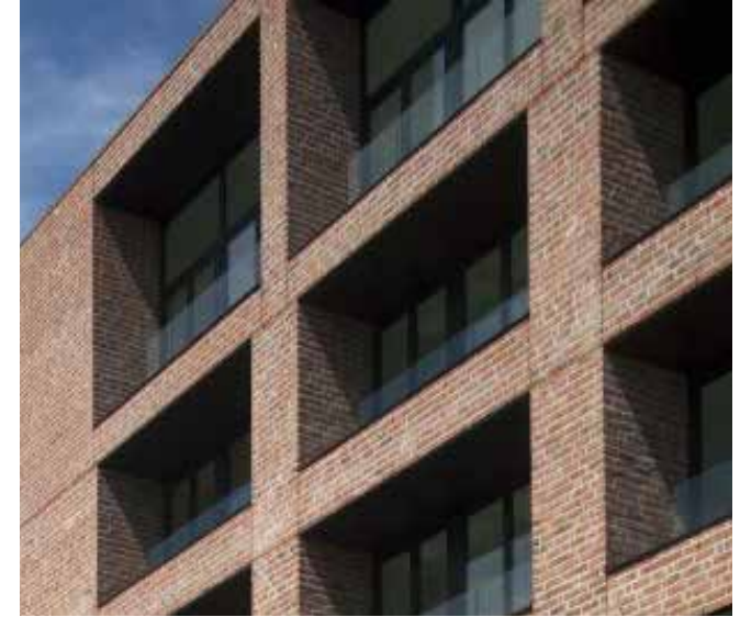
Figuur 3.26 Loggia (met dichte, transparante balustrade) en raampartijen geven plasticiteit aan de gevels
