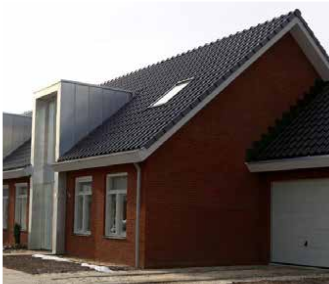
Figuur 3.36 Overgang tussen gevel en kap bij levensloopbestendige woning
