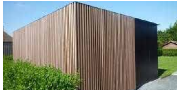
Figuur 4.4 Houten behuizing voor de voorzijde van de energieunit, de overige ruimte rondom kan van een haag worden voorzien
