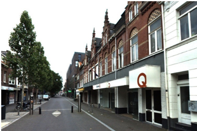
Luifels die het zicht op de kwalitatieve gevels daarboven ontnemen
