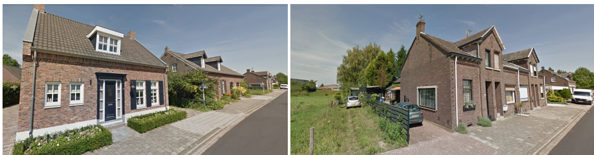
Figuur 5: bebouwing Tegelseweg 1 en 3 respectievelijk Tegelseweg 5
