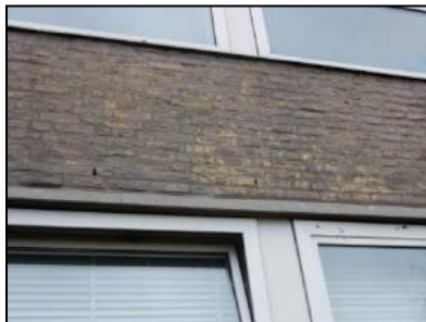
Figuur 9. Geschikte spouwmuur openingen met toegang tot de spouwmuur van het gebouw waar vleermuizen gebruik van kunnen maken.
