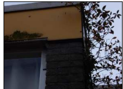
Figuur 11. Ruimtes achter betimmering en onder de dakrand bieden potentiële weggroep mogelijkheden voor vleermuizen.
