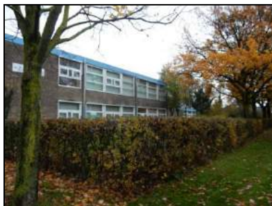
Figuur 3. Noordwestelijke zijde voormalige school (gebouw 1).
