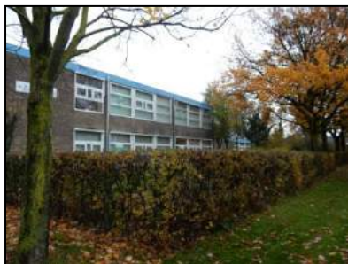
Figuur 3. Noordwestelijke zijde voormalige school (gebouw 1).
