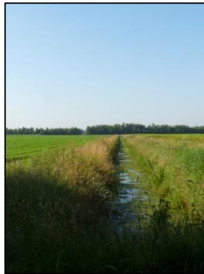
Figuur 10. De aanvoerleiding van de Langevenseloop.
