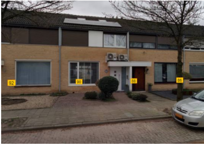
Woning met installaties.
