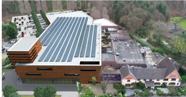
Positief geadviseerde Taurus gebouw Rijksweg 181
