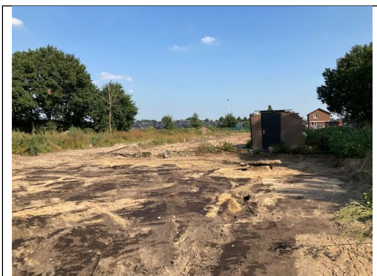
Foto 15: ontgraving bodem B8 gezien vanuit het westen
