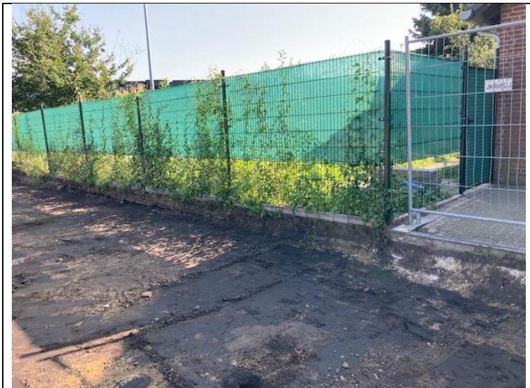
Foto 8: ontgraven tot aan de perceelsgrens
