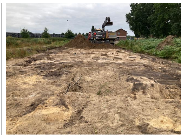
Foto 3: ontgraven van de bodem B1 en B2 gezien vanuit het westen
