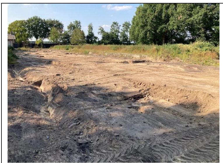
Foto 5: ontgraven van de bodem B3, B4 en B5 gezien vanuit het oosten
