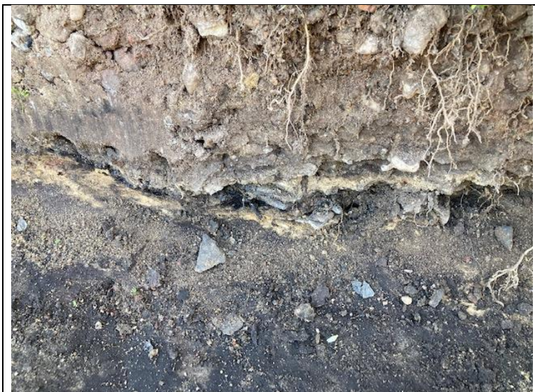
Foto 9: duidelijke restverontreiniging met asbestmaterialen bij de perceelsgrens
