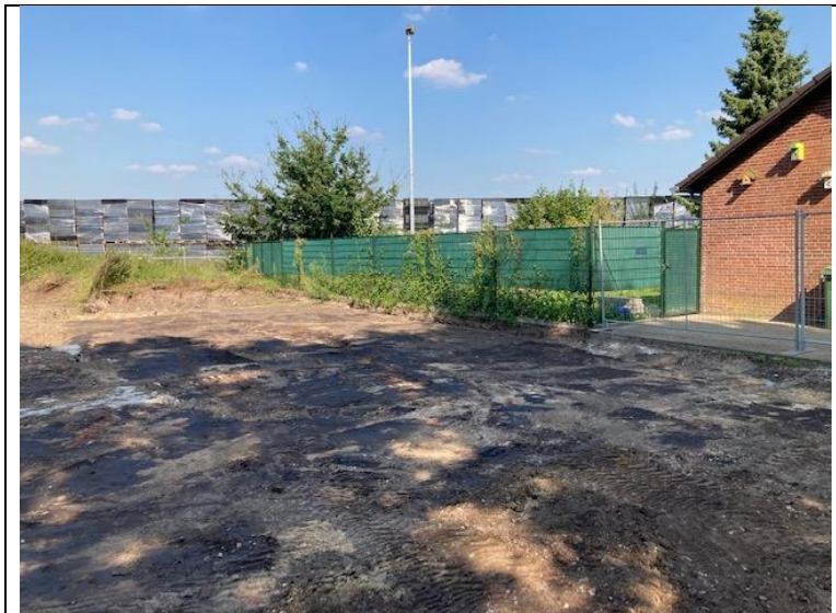
Foto 10: overzicht ontgraving bodem B7 en B6
