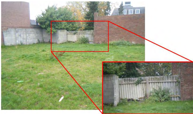
Afbeelding 2. Perceelsscheiding van asbestverdacht materiaal
