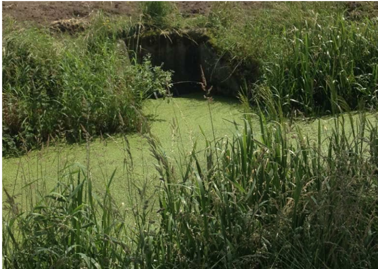
Uitmonding riooloverstort op beek
