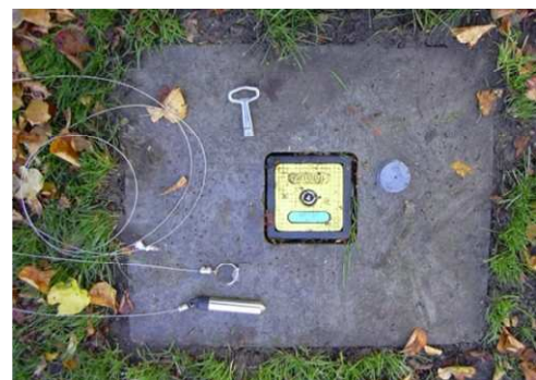
Peilbuis putje met diver (automatische niveaumeter)
