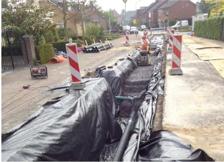
"Anders omgaan met hemelwater" Aanleg infiltratiesleuf, meelifen met wegonderhoud
