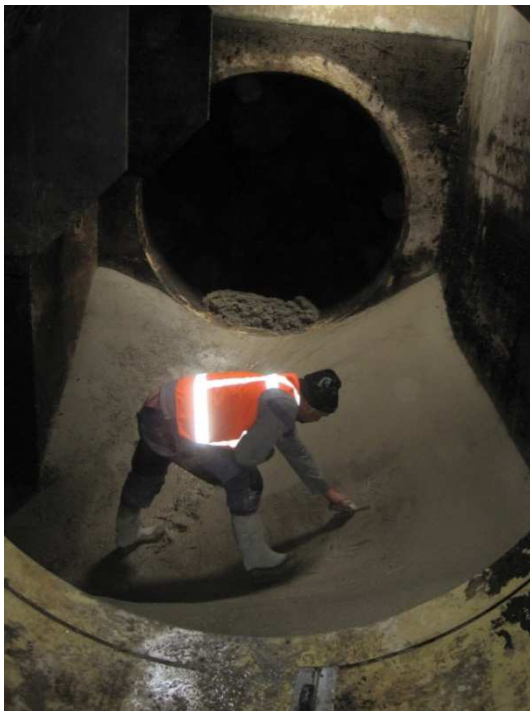
Afwerking putbodem met stroomprofiel in een van de stuwputten
