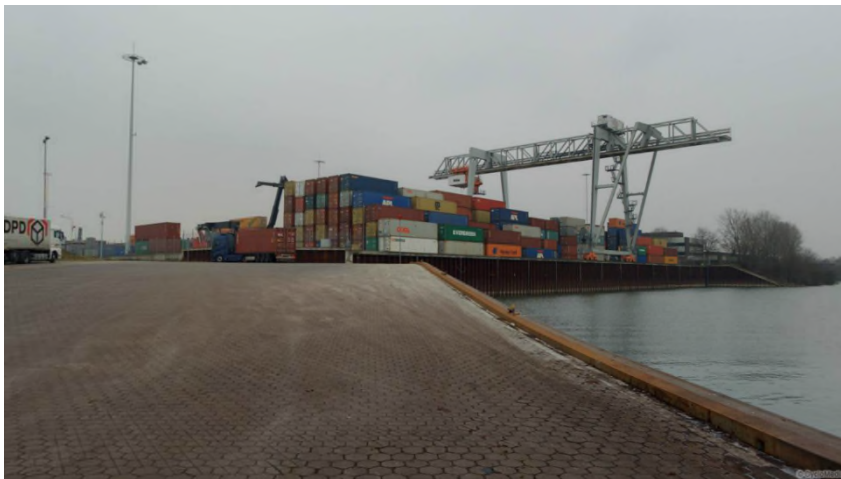
Figuur 5, 6 en 7: foto's bestaande situatie Barge Terminal Venlo
