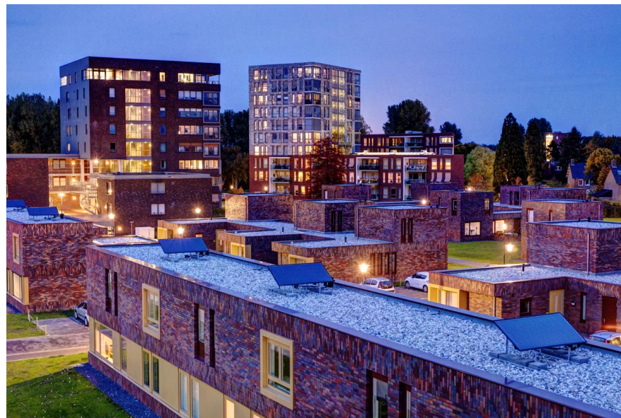
De nieuwbouw in Park Rijnbeek is duurzaam en energiezuinig uitgevoerd. Op een aantal daken zijn zonnepanelen aangebracht.
