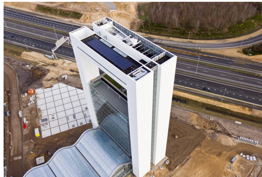
Vanaf de grond is het niet te zien, maar ook de Villa Flora is voorzien van zonnepanelen.
