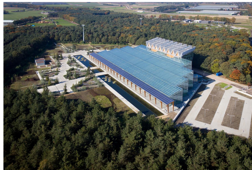
Villa Flora heeft één van de grootste zonnestroom-installaties in Venlo.
