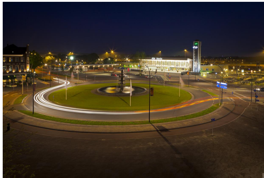
In 2013 is Venlo gestart met een grootschalige energiebesparing in de Openbare Verlichting. Het merendeel van de lantarenpalen wordt uitgerust met energiezuinige LED-armaturen.
