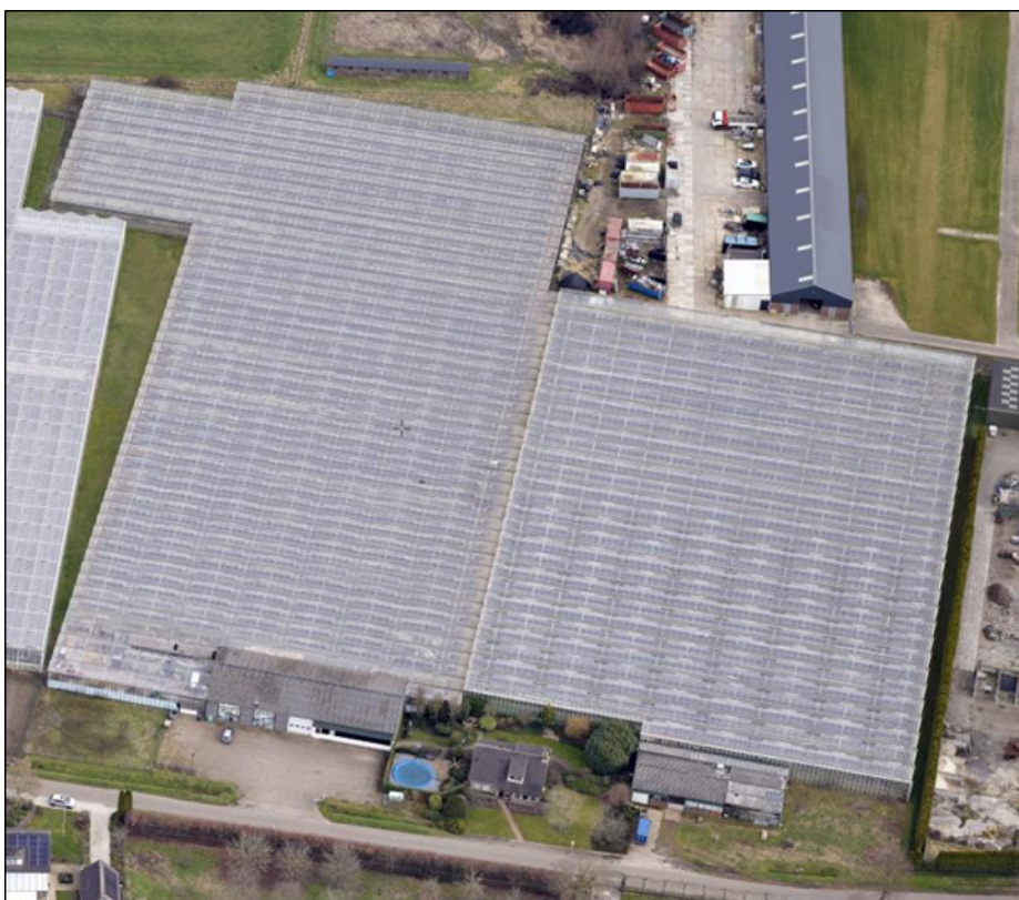
Foto bestaande situatie gezien vanuit de Vorstweg
