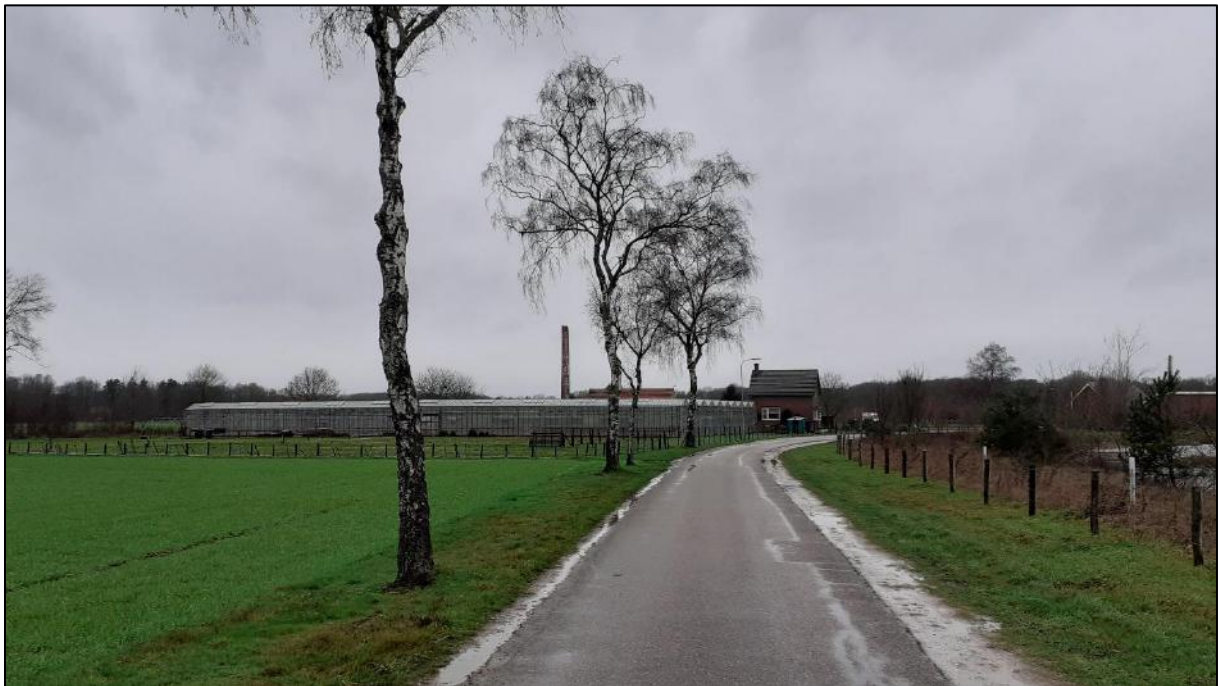
Afbeelding 3 impressie aanzicht van het plangebied gezien vanaf noordoostelijke zijde, de kas en schoorsteen bepalen het beeld.
