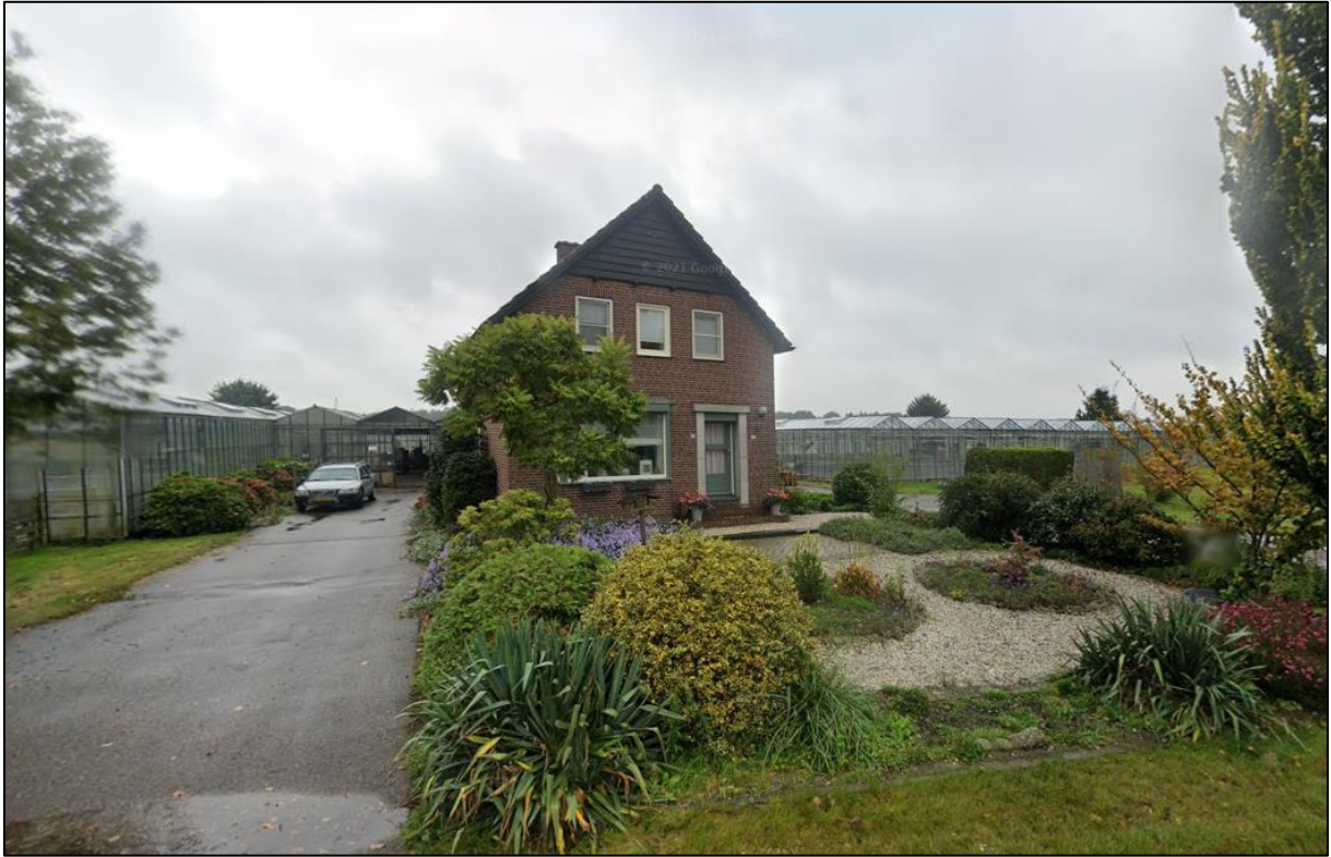
Afbeelding 4. Impressie van de woning gezien vanaf de Brandemolen met links en rechts daarvan de te slopen kassen.
