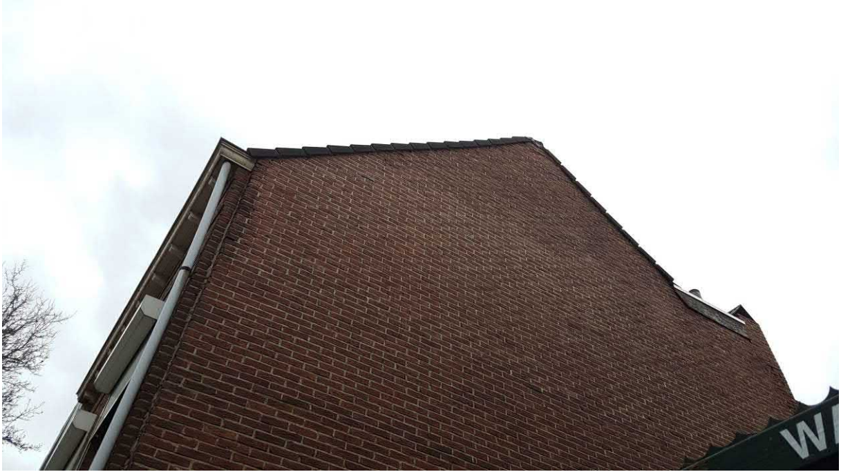
Foto 7: de dakranden sluiten na inspectie netjes aan.
