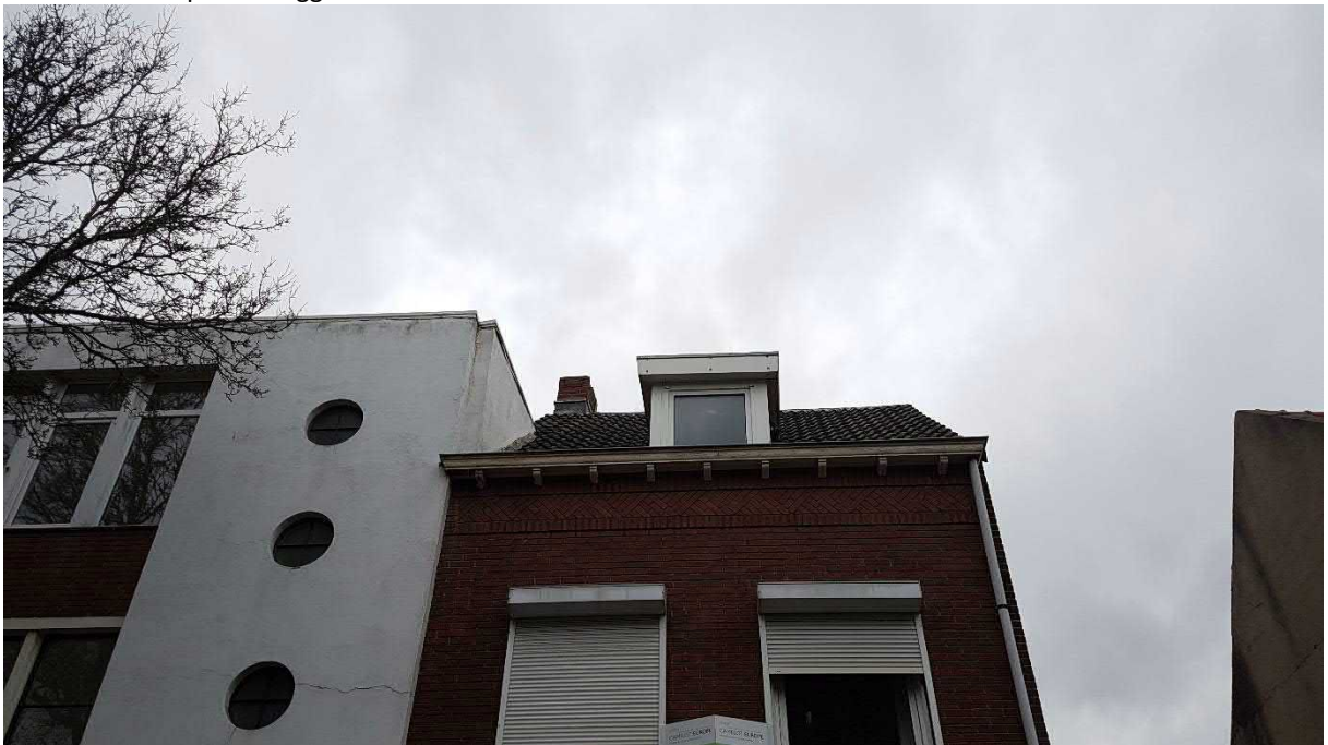
Foto 14: de dakpannen liggen recht en sluiten nauw aan.
