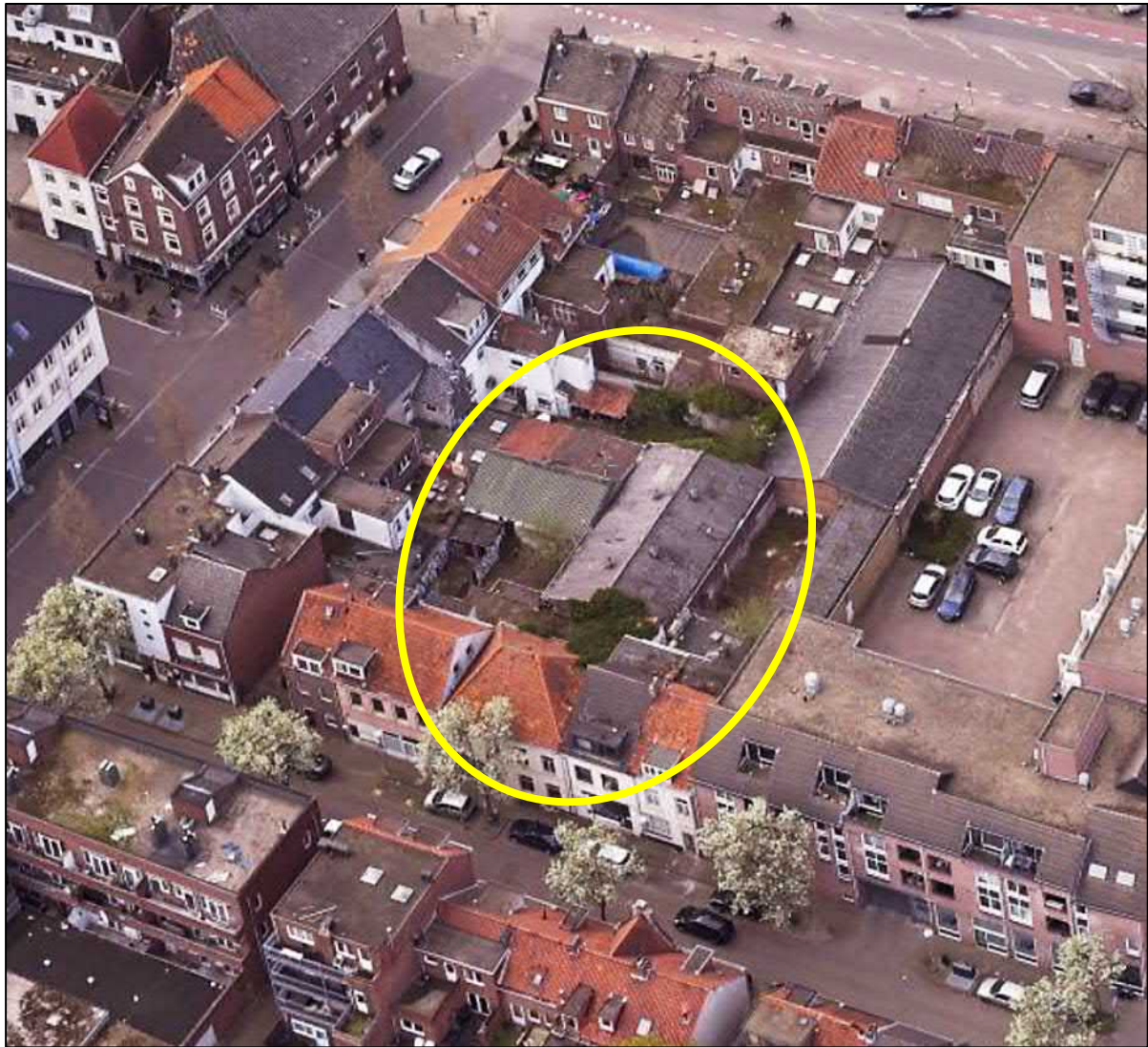
Afb. 4: Vogelvluchtopname vanuit het oosten met geel omlijnd indicatief het plangebied.
