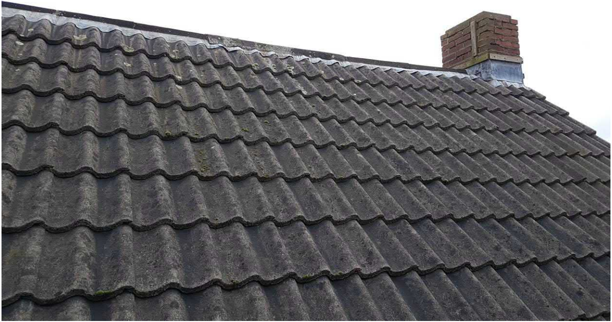
Foto 13: de dakpannen liggen recht en sluiten nauw aan.
