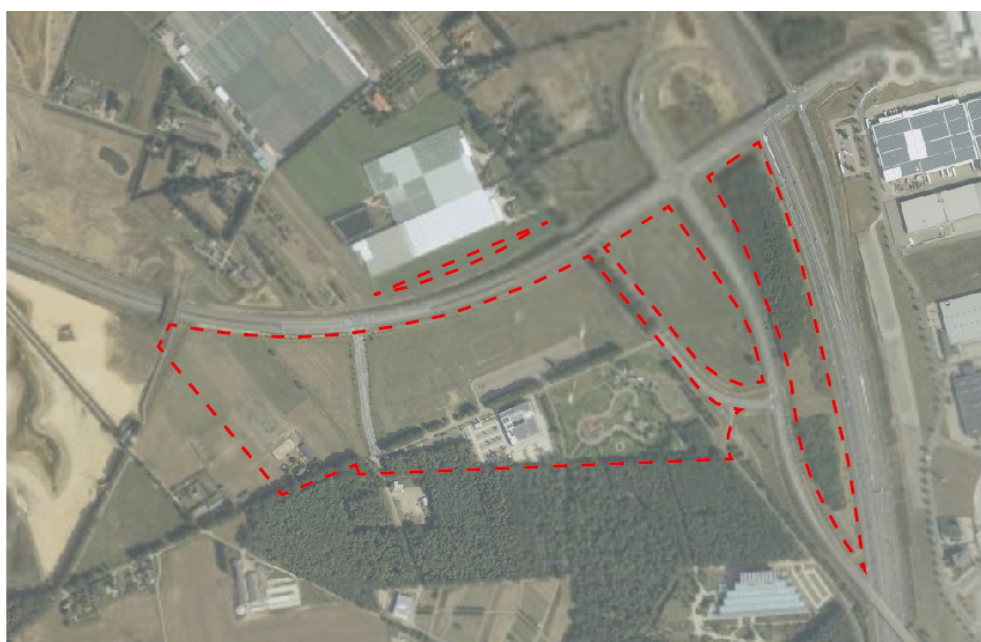
Figuur 2.1: Plangebied op luchtfoto
