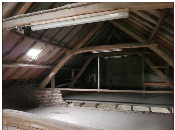
Figuur 9. Binnenkant te verbouwen gedeelte
