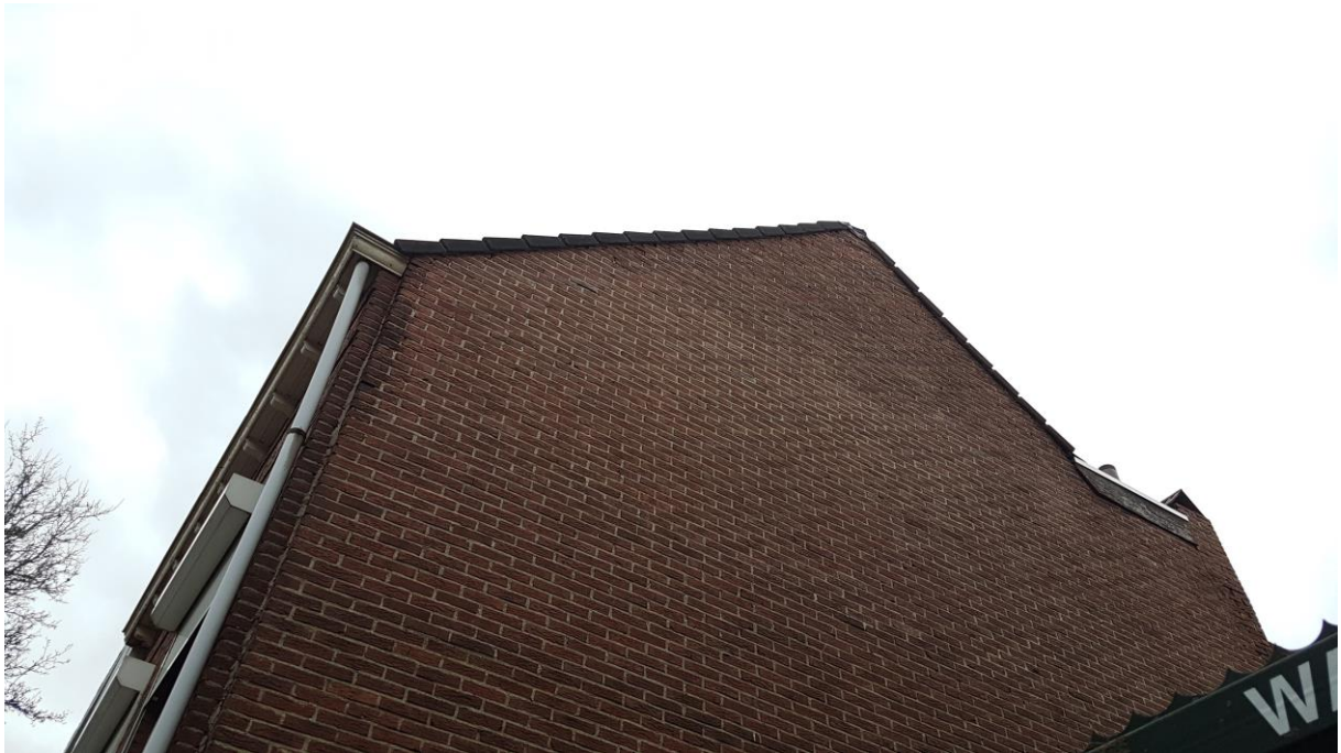
Foto 7: de dakranden sluiten na inspectie netjes aan.
