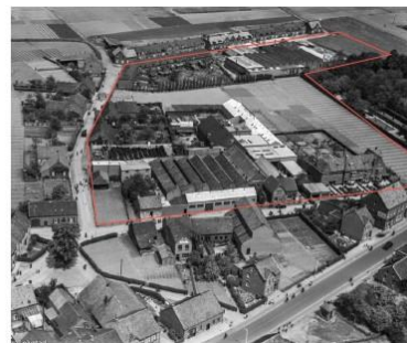
Luchtfoto 1923 de typerende dakvorm en baksteen komt terug in nieuwe de plannorming
