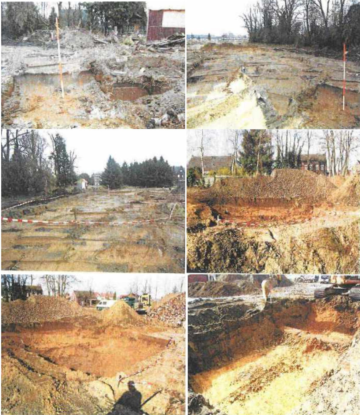
Figuur 15: Fotomateriaal van de bodemsaneringswerkzaamheden 2005.
