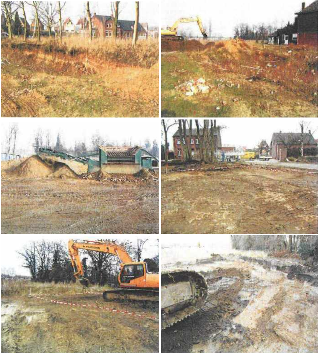
Figuur 14: Fotomateriaal van de bodemsaneringswerkzaamheden 2005.
