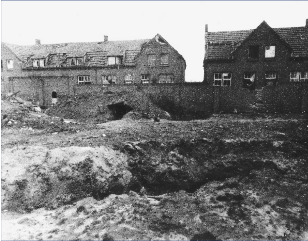
Figuur 10: Aanzicht loopgraven aan de Veldstraat op het T.M.I. terrein. Er is een schuilvoorziening ingericht tegen een muur en op de achtergrond zijn beschadigde woningen zichtbaar.
