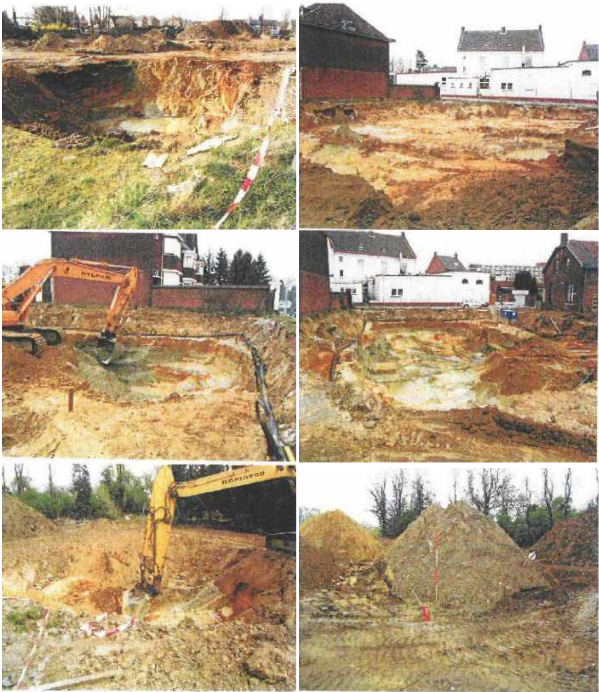
Figuur 16: Fotomateriaal van de bodemsaneringswerkzaamheden 2005.
