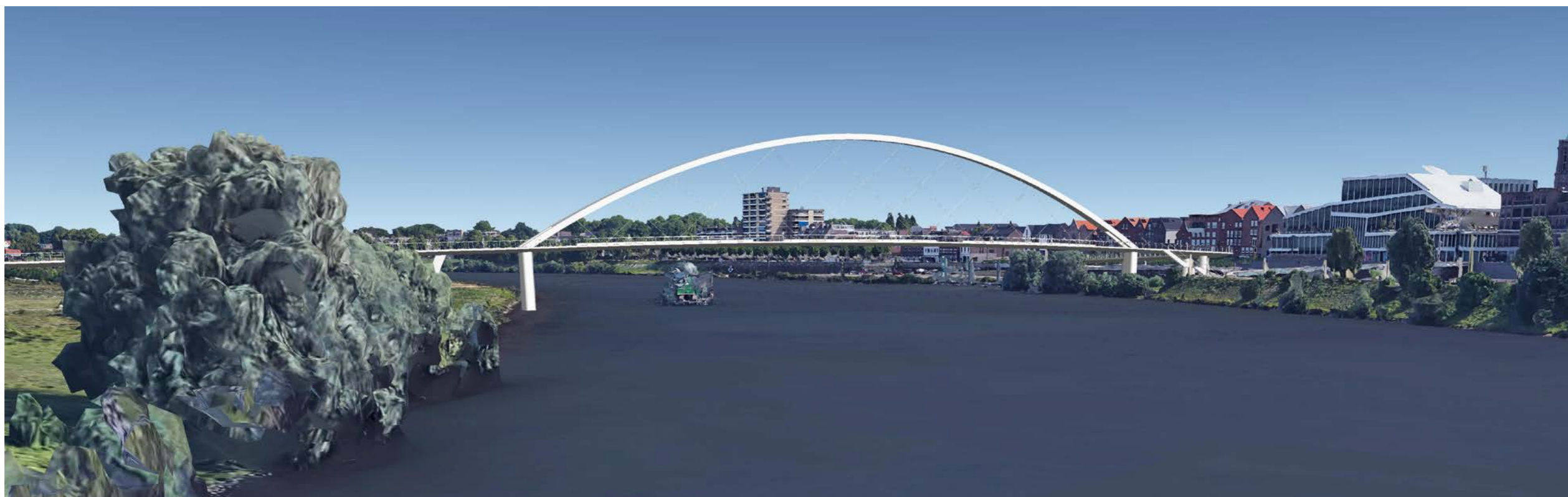
Aanzicht vanaf het zuiden.
