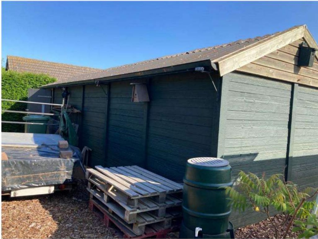
• Afbeelding 8: te slopen bijgebouw
