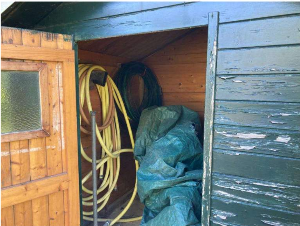
• Afbeelding 9: binnenzijde te slopen bijgebouw
