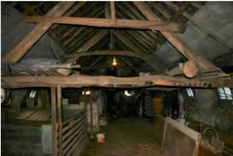
Figuur 4.4.5. De voormalige stal met dakbeschot aan het onderste deel van het dak.
