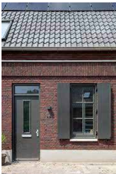
landelijke elementen: luiken, plint, combinatie houten gevelbekleding en metselwerk
