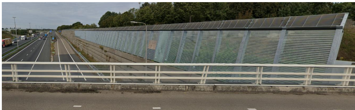
figuur 9 Voorbeeld van de gerealiseerde diffractoren op het hoge geluidscherm langs de A73 bij Annakamp (bron: Google Streetview)
