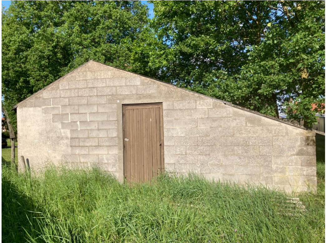
• Afbeelding 12: Te slopen bebouwing
