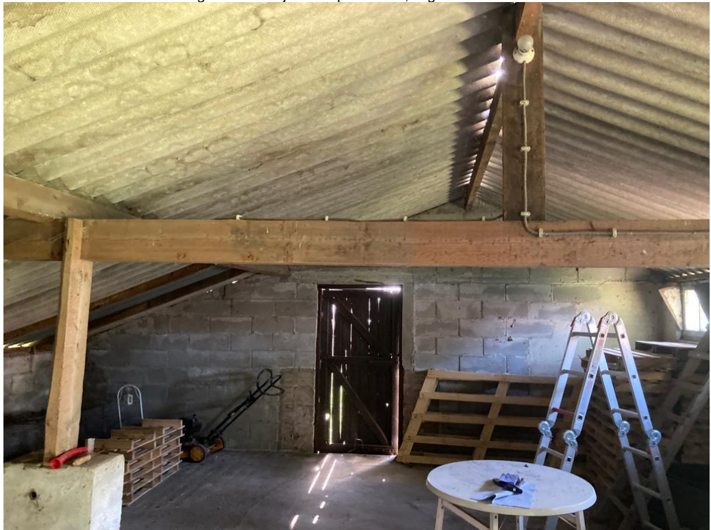
• Afbeelding 16: Binnenzijde te slopen schuur, ongeïsoleerd
