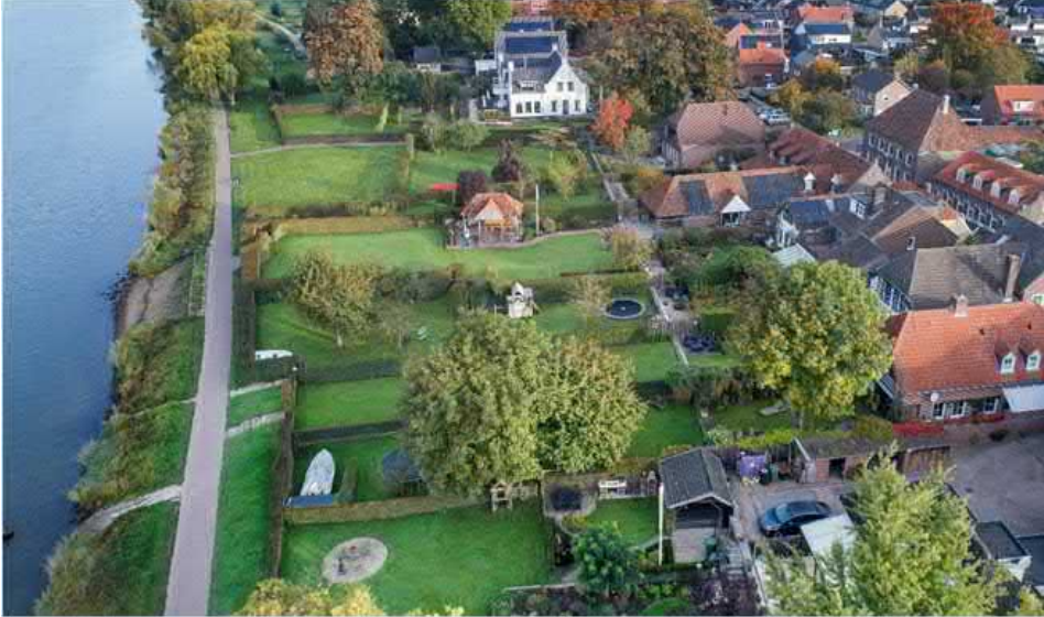
Figuur 10: de demontabele kering door de achtertuinen van adressen aan de Maasstraat in Arcen.
