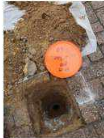
Foto: materiaal proefgat 008 (25-50)
