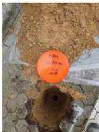
Foto: materiaal proefgat 020 (30-55)
