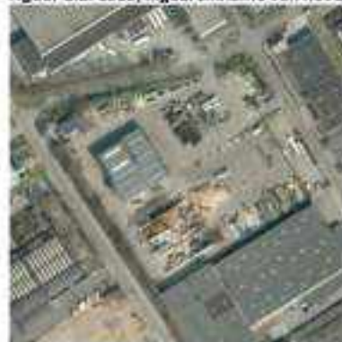
Figuur 2.4: 2009, verharding zuidelijke terreinheft en aanleg buitenbunkers
