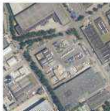
Figuur 2.6: 2019, dak van overslaghal deels verwoest door brand
