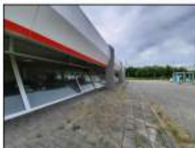
Figuur 4. Impressie voormalige autogarage op planlocatie.
