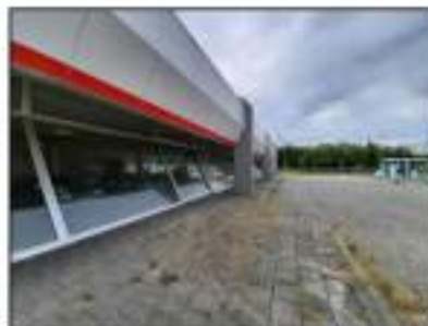
Figuur 3. Impressie voormalige autogarage op planlocatie.
