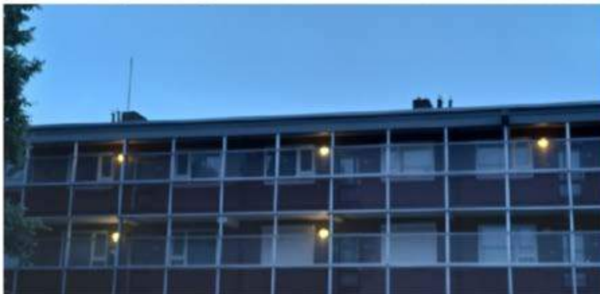
Foto's 4a,b: locatie E (achtergevel van de zuidvleugel van het complex), de vleermuisverblijfplaats bevindt zich mogelijk in de schoorsteen, die achter de boom, links op de foto, verscholen is, nabij de zijgevel (locatie F)
