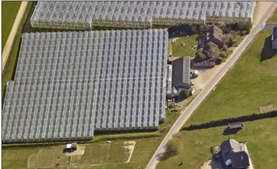
Foto's bestaande situatie
