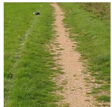
Figuur 16. Aanleggen wandelpad
