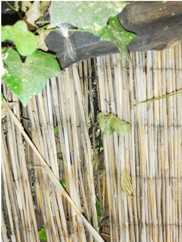
Figuur 4.2.2. Het tuinhuisje heeft enkelwandige wanden van rietmat (links) en een golfplaten dak (rechts).
