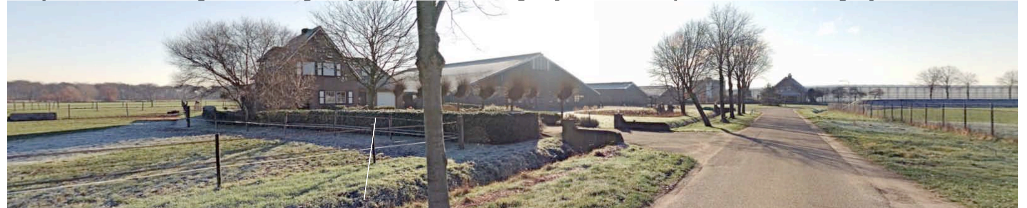
bedrijfsgebouwen tonen zich kaal. De hagen en bomen nabij de woning vormen een passend kader.
