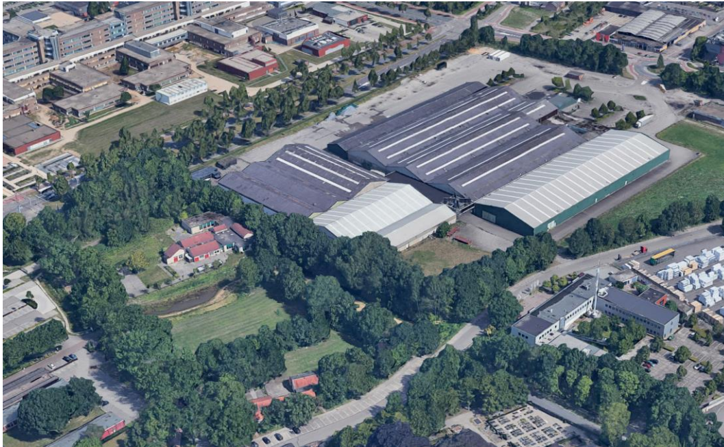
Afbeelding 2.1: huidige situatie (inmiddels enkele loodsen Veilingterrein gesloopt)
