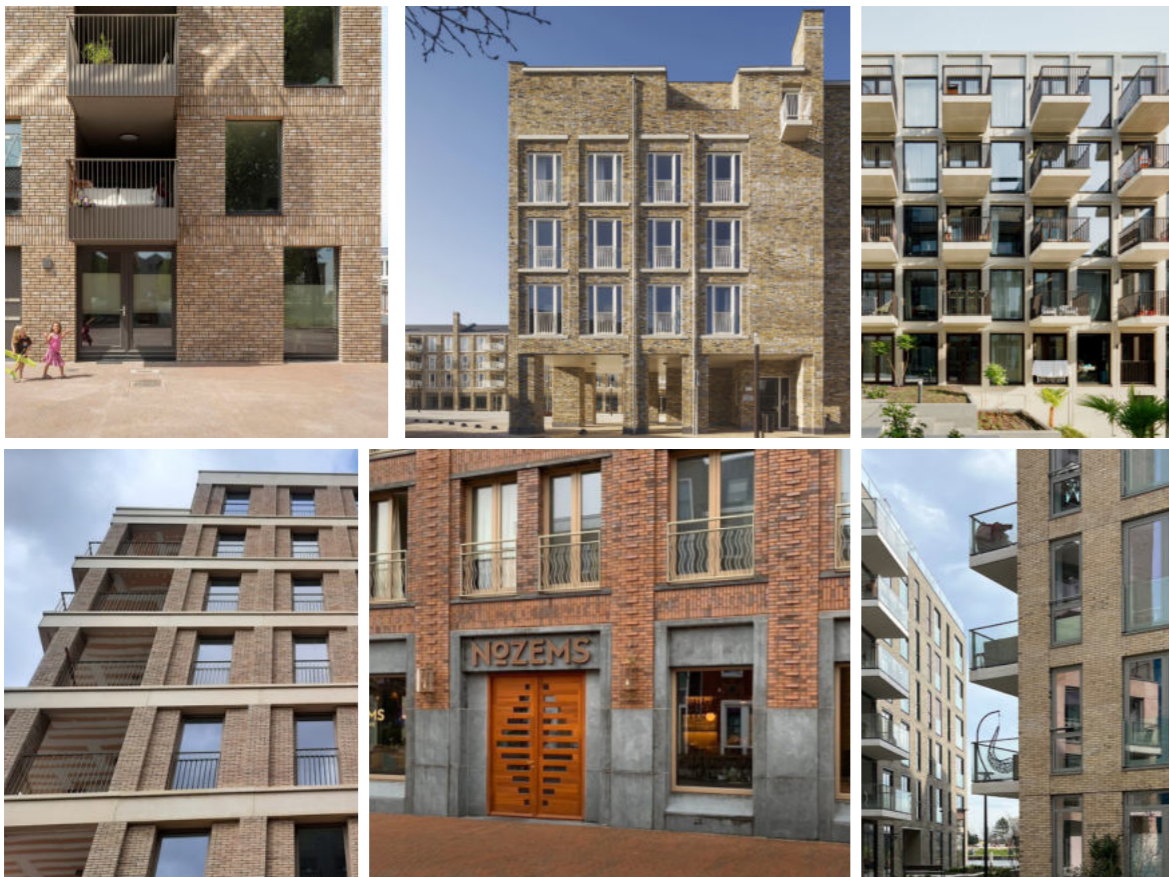
Materiaal, kleur, textuur, detaillering gevels
