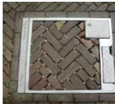
Putkast ingepast in verharding
