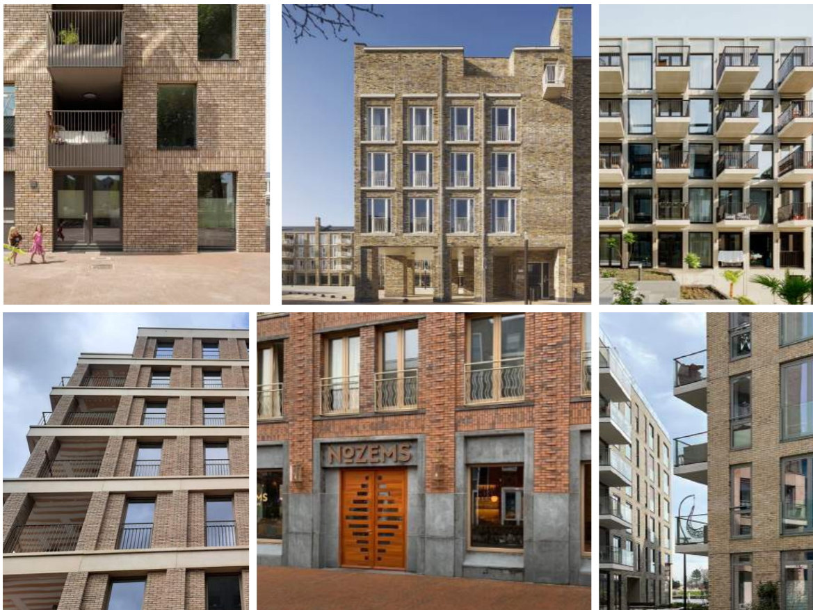
Materiaal, kleur, textuur, detaillering gevels
