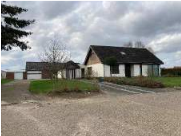
Foto 1 Aanzicht op het woonhuis van uit de Paaweg
