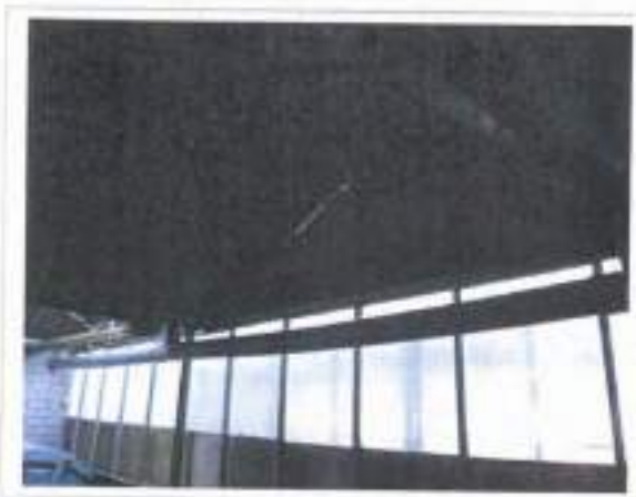
Asbesthoudende wandbeplating en beplating tegen de nokjes aan de binnenzijde van de kas.
