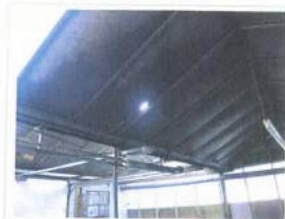
Asbesthoudend plaatmateriaal tegen de binnenzijde van het dak van de kas.
