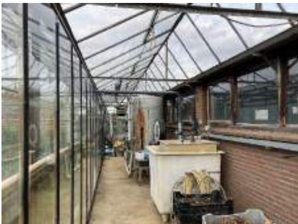
Foto 11 Bemestingsruimte met ontijzeringsinstallatie en substraatbakken voor aanmaak van meststoffen
