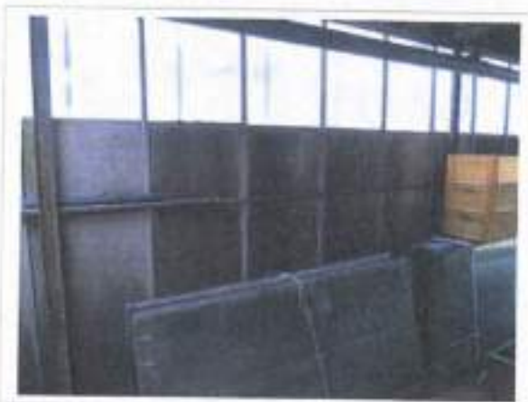
Asbesthoudende wandbeplating en beplating tegen de nokjes aan de binnenzijde van de kas.
