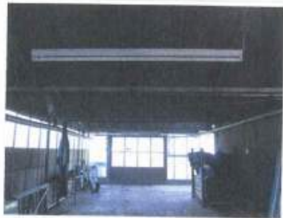
Asbesthoudend plaatmateriaal tegen de binnenzijde van het dak van de kas.
