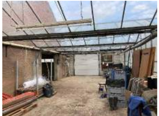
Foto 10 Corridor die doorgang biedt vanuit de oprit naar de achterliggende tuinderskas
