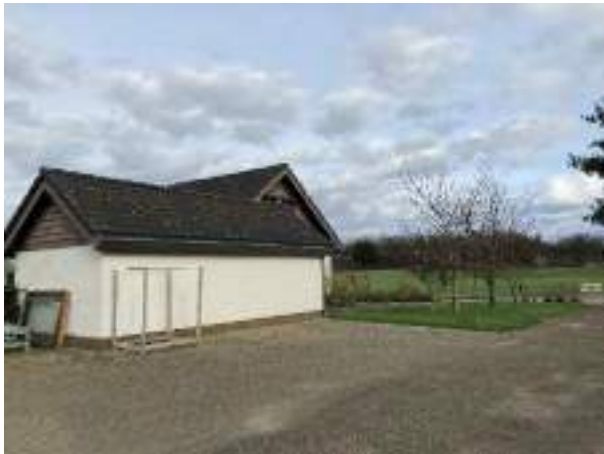
Foto 3 Aanzicht op de garage behorende bij de woning
