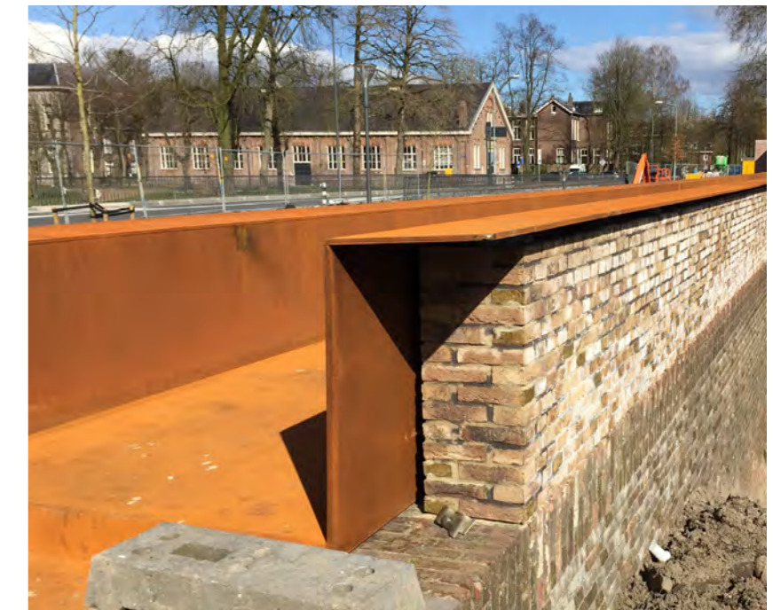
Vestingwand opgraven en zichtbaar maken
